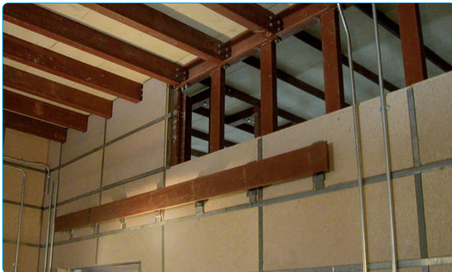
St. James Hospital (Dublino). Fase di cantiere
